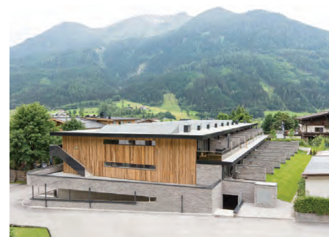
Blick von der neuen Anlage am Sonnenhang auf die „Residenz Neukirchen - Wildkogelbahnen“. Dieses Projekt wurde vor über einem Jahr von den Bauherren Otto Hochwimmer, Christian Klausson und Ton Jansen errichtet.
