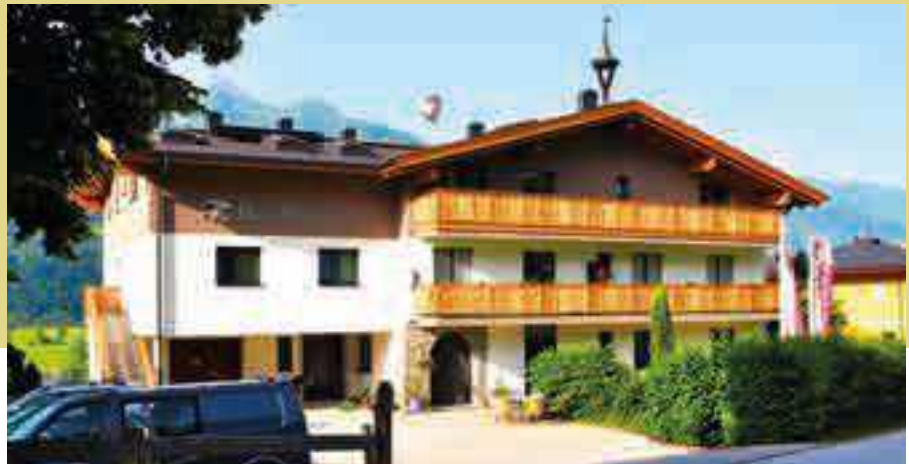
Das Haus Piesendorf verfügt nach dem Umbau über ein zusätzliches Stockwerk.
